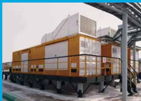
Комплекс по выработке азота
