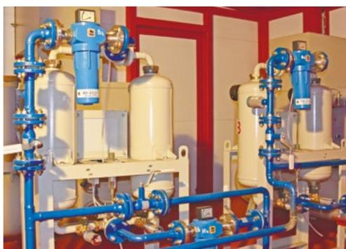
*Магистральные сепараторы циклонного типа серии СЦ.*
