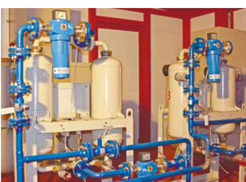
*Магистральные сепараторы циклонного типа серии СЦ.*
