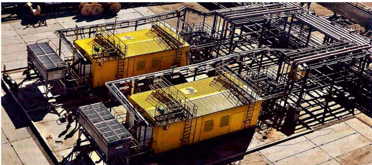
Модульность обеспечивает удобство транспортировки. Блок-контейнер позволяет поддерживать рабочие температуры компрессорного оборудования от -60 до +40 °С.
