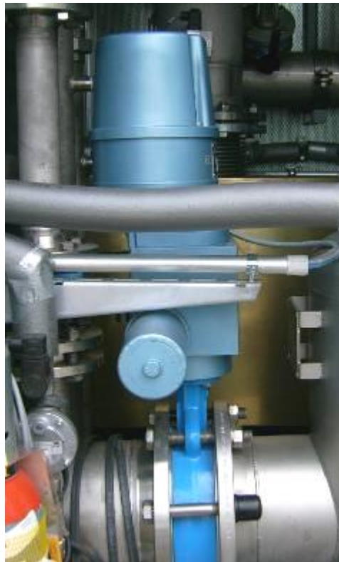
Затвор с быстрозাপорным электроприводом
